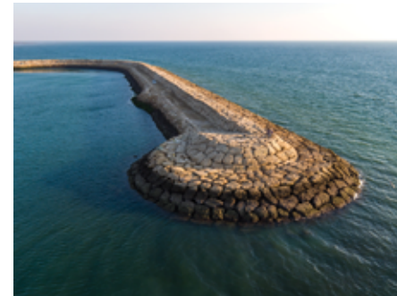
موج شکن بنادر چند منظوره جنوب
