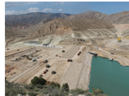
عملیات اجرایی سد گل‌مندر ( استان خراسان شمالی) Golmandareh dam (North Khorasan Province)
