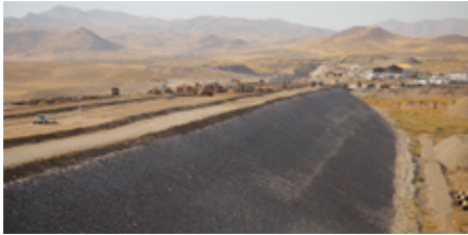
عملیات اجرای سد نهب ( استان قزوین) Naheb dam (Qazwin Province)
