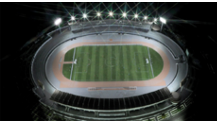
پروژه استادیوم ۱۵۰۰۰ نفری زنجان 15000-Seat Stadium in Zanjan
