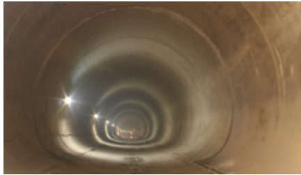
تونل خط ۴ مترو (استان تهران) Tehran subway 4th line tunneling (Thran Province)
