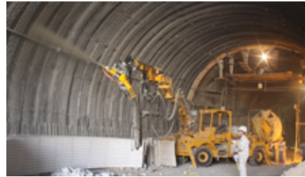
تونل راه دسترسی سد ماملو Tunnel of Road to Mamloo Dam
