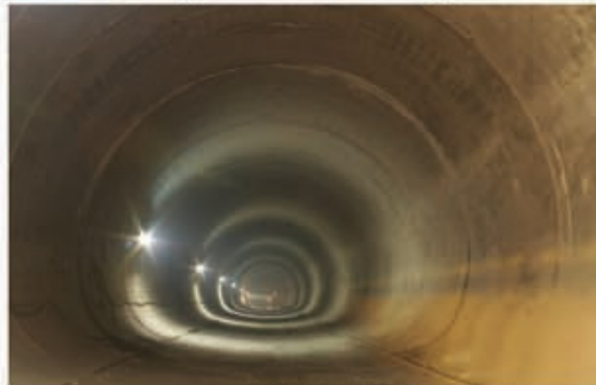
تونل خط ۴ مترو (استان تهران) Tehran subway 4th line tunneling (Tehran Province)
