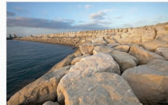
موج شکن بنادر چند منظوره جنوب Breakwater
