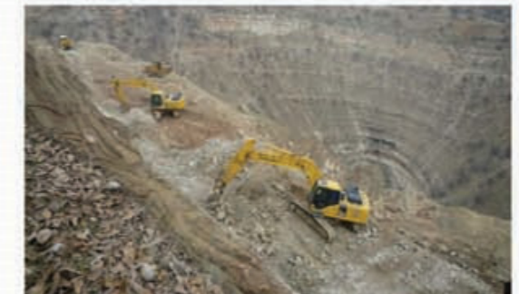
عملیات اجرایی سد پارسیان (استان فارس)
