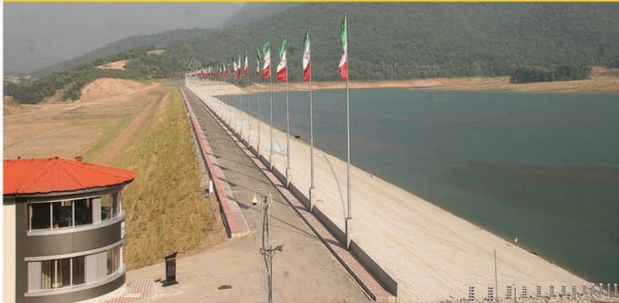
سد کبودوال یکی از عریض ترین سدهای کشور با عرض ۱۳۷۳ متر (استان گلستان) Kabodval dam with 1373 m long crest (Golestan Province)
