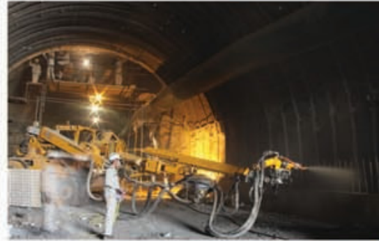
اجرای شاتکریت الیافی بجای لاینینگ نهایی جاده جابگزین سد ماملو (استان تهران) Fiber Shotcreting (instead of conventional lining) (Tehran Province)
