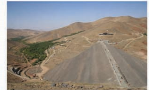
عملیات اجرایی سد سرابی یکی از مرتفع ترین سدهای کشور با ۷۸ متر ارتفاع (استان همدان) Sarabi earth dam with the height of 78 m (Hamaedan Province)
