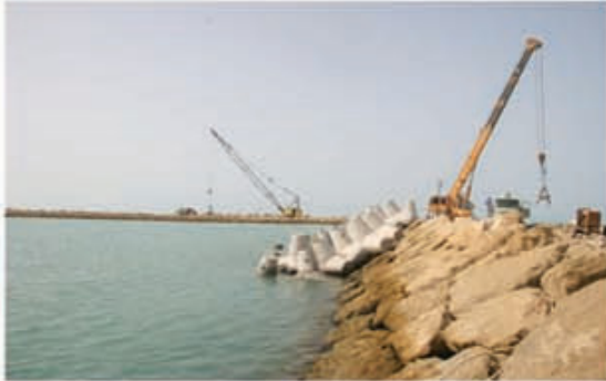
موج شکن بندر صیادی گوکسر (هرمزگان) Gouksar fishing port wharf and breakwater (Hormozgan Province)
