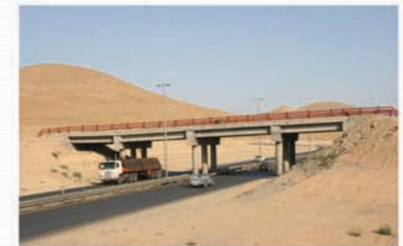
پل تقاطع اراک بروجرد (استان مرکزی) Arak-Broujerd cross-road bridge (Markazi Province)
