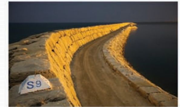
موج شکن بنادر چند منظوره جنوب Breakwater
