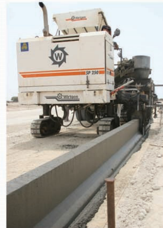
جدول کاری درجا با دستگاه SP250 (کیش) In place concrete block installment with SP250 machine (Kish)
